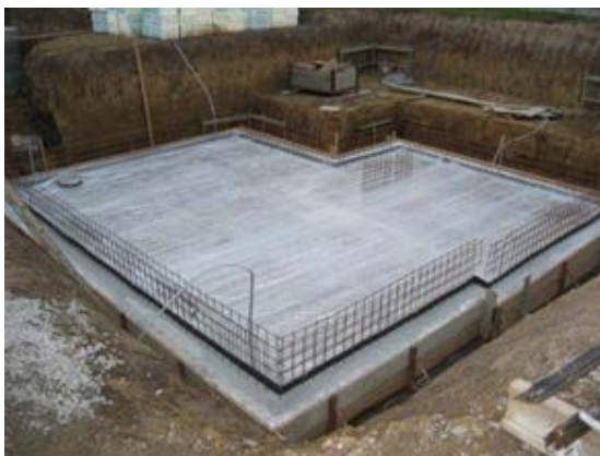
FrISCHE Betondecke am Bau
