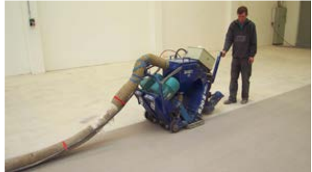
Kugelstrahlmaschine im Einsatz
