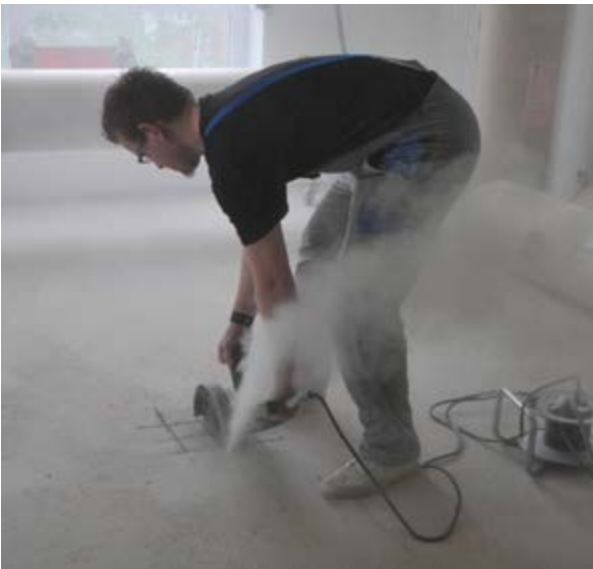
Entnahme einer Estrichprobe
