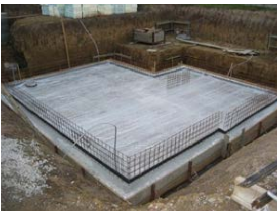
FrISChe Betondecke am Bau
