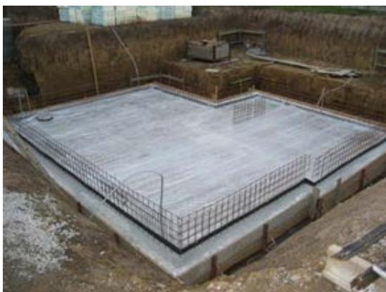
Frische Betondecke am Bau
