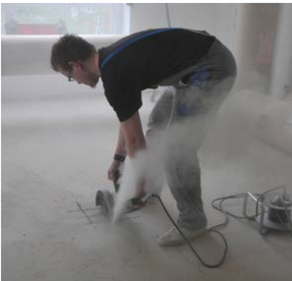
Entnahme einer Estrichprobe
