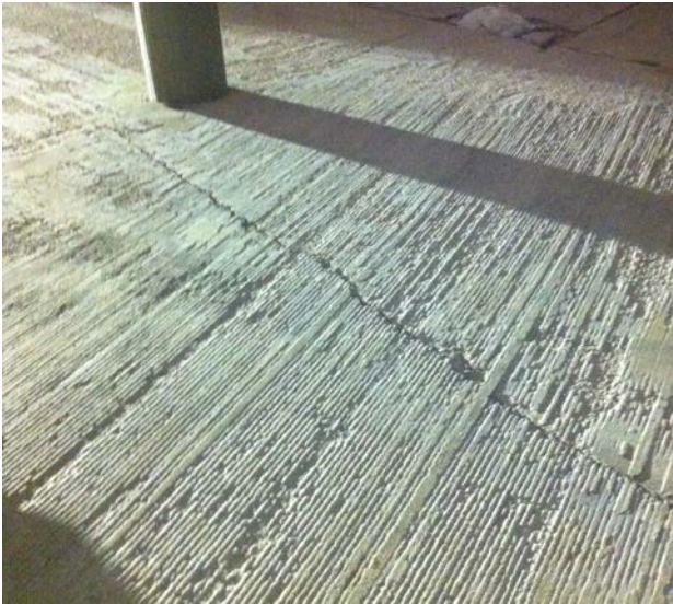
Oberflächenbild nach Fräsarbeiten
