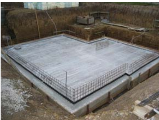
FrISChe Betondecke am Bau
