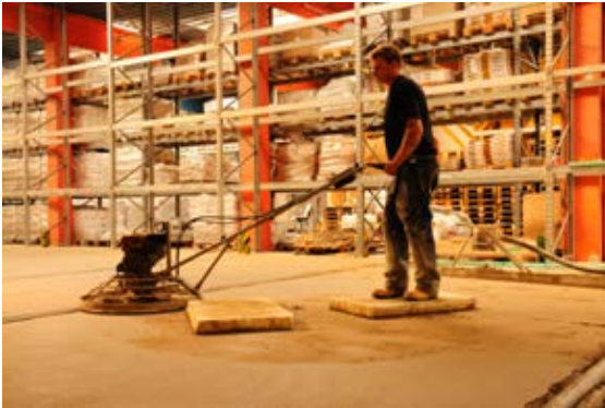
Glätten eines Schnell-Estrichs
