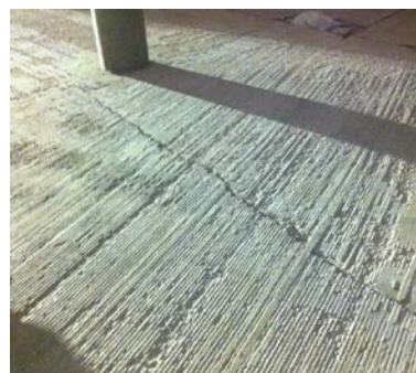
Oberflächenbild nach Fräsarbeiten
