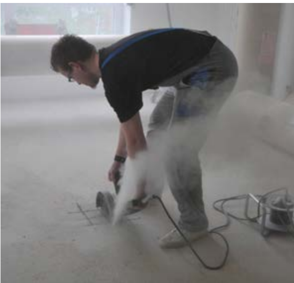
Entnahme einer Estrichprobe
